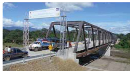
Paso Real Bridge (Nicaragua)
